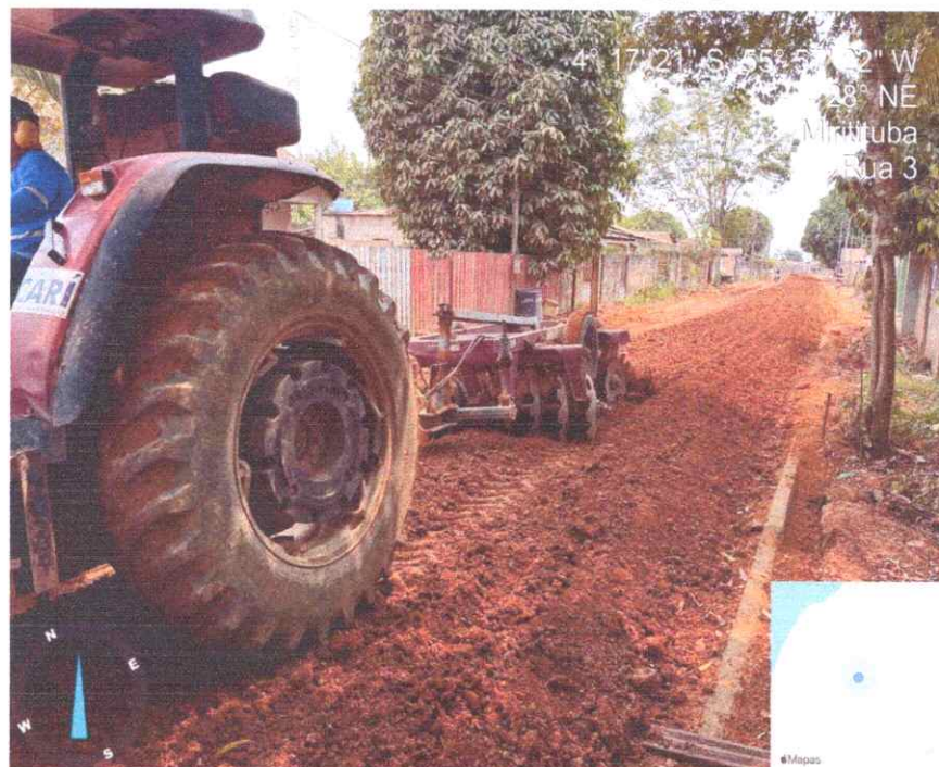
FOTO 5: TERRAPLENAGEM DA RUA 3
