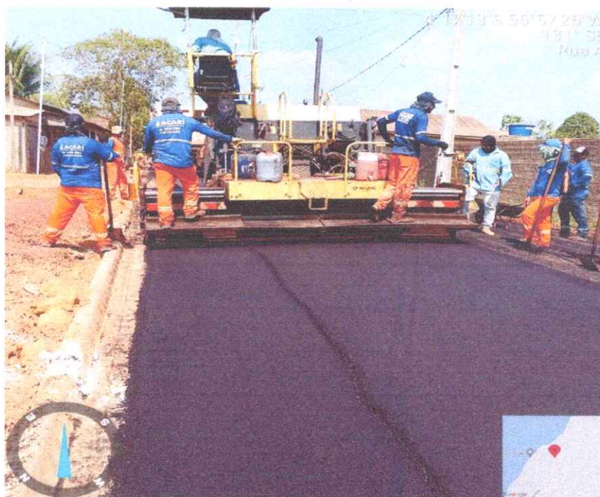
FOTO 4: PAVIMENTAÇÃO RUA A
