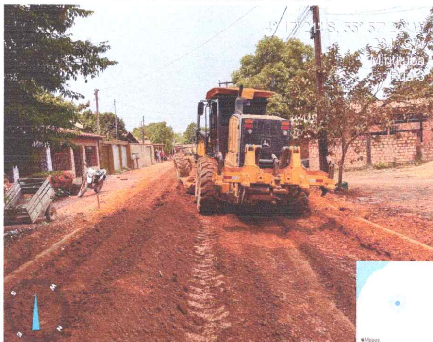
FOTO 6: TERRAPLENAGEM DA RUA 3
