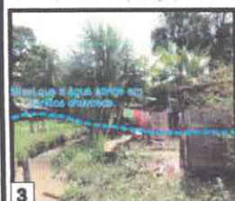
3 Barragem que impede os detritos (água servida, lixo e água) de sair para o rio no caso de inundação do igarapé Orundo.
