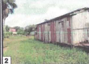
2 Prédio construído sobre a planície de inundação do igarapé Orundo.
