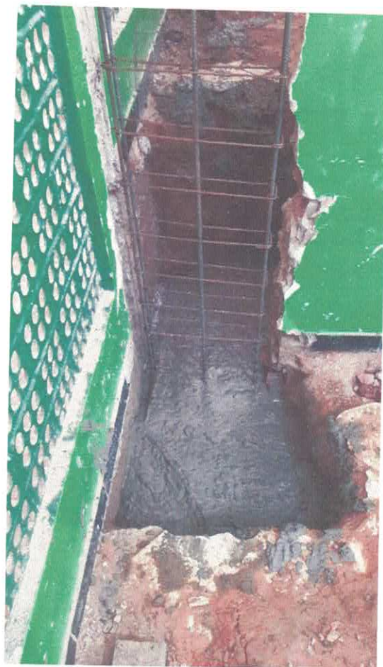
Fig. 1: Demolição de trecho de alvenaria, armação do pilar e concretagem da fundação.
