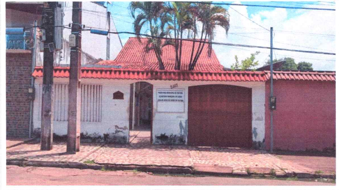
Foto 01: Frente do imóvel
