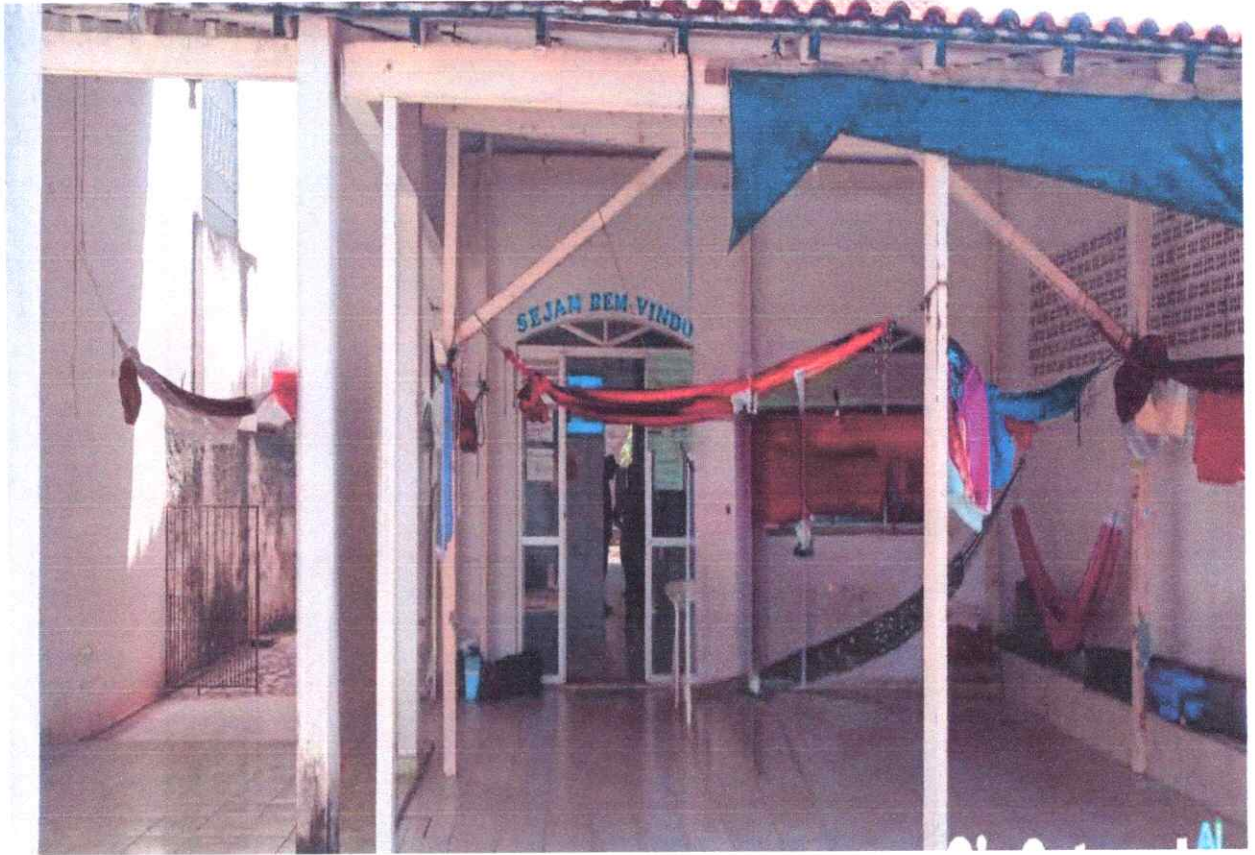
Foto 13: Área externa coberta
