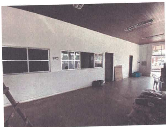
FOTO 07 Sala de Carga .
