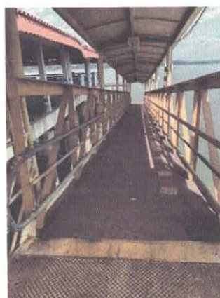
FOTO 22 Rampa móvel de acesso a Balsa das Lanchas.
