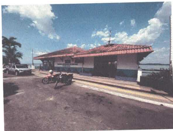
FOTO 01 Faixada frontal do Terminal hidroviário de Itaituba.
