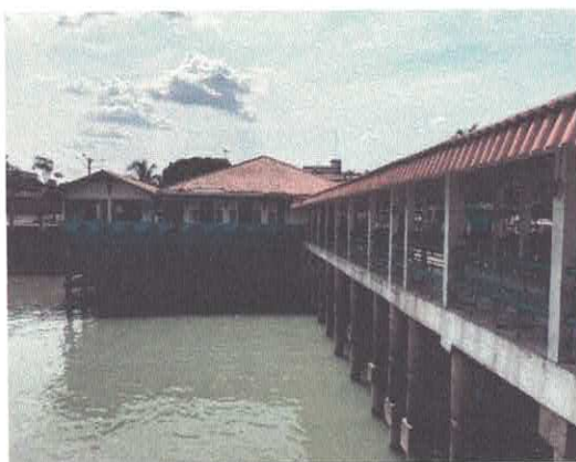
FOTO 21 Vista externa da Sala de Embarque e Rampa de Embarque.
